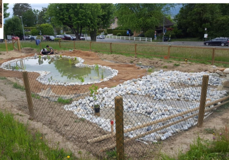
Pose de la fibre de coco (soutien des berges) et milieux aquatiques pionniers au 1 er plan.
